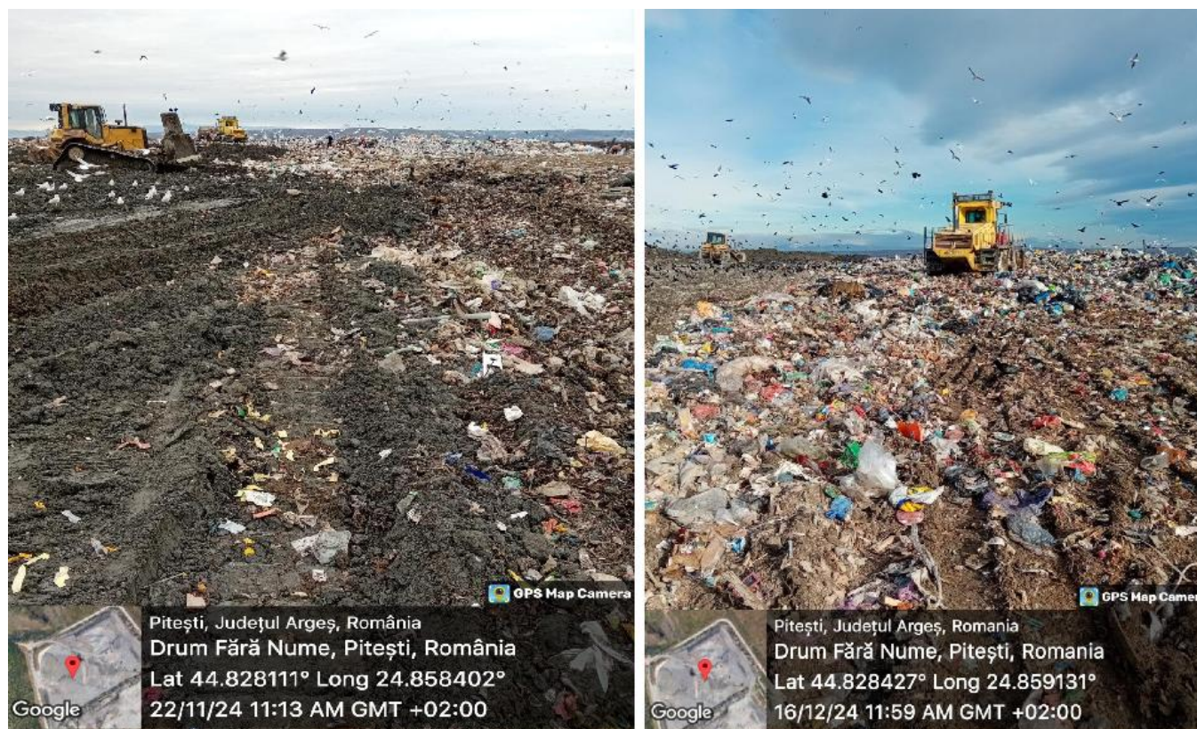
Foto 4: Depozitarea, compactarea si acoperirea deseului menajer in celula nr. 2
