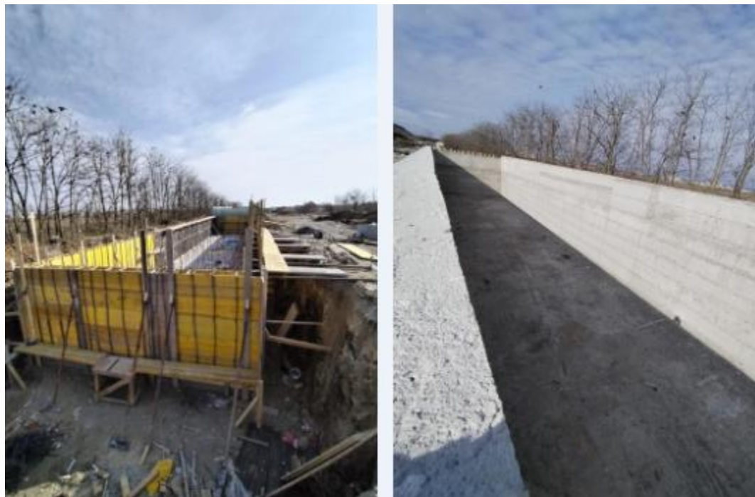
Foto 1: Stadiul realizarii lucrarii- bazin de linistre 2880 mp
