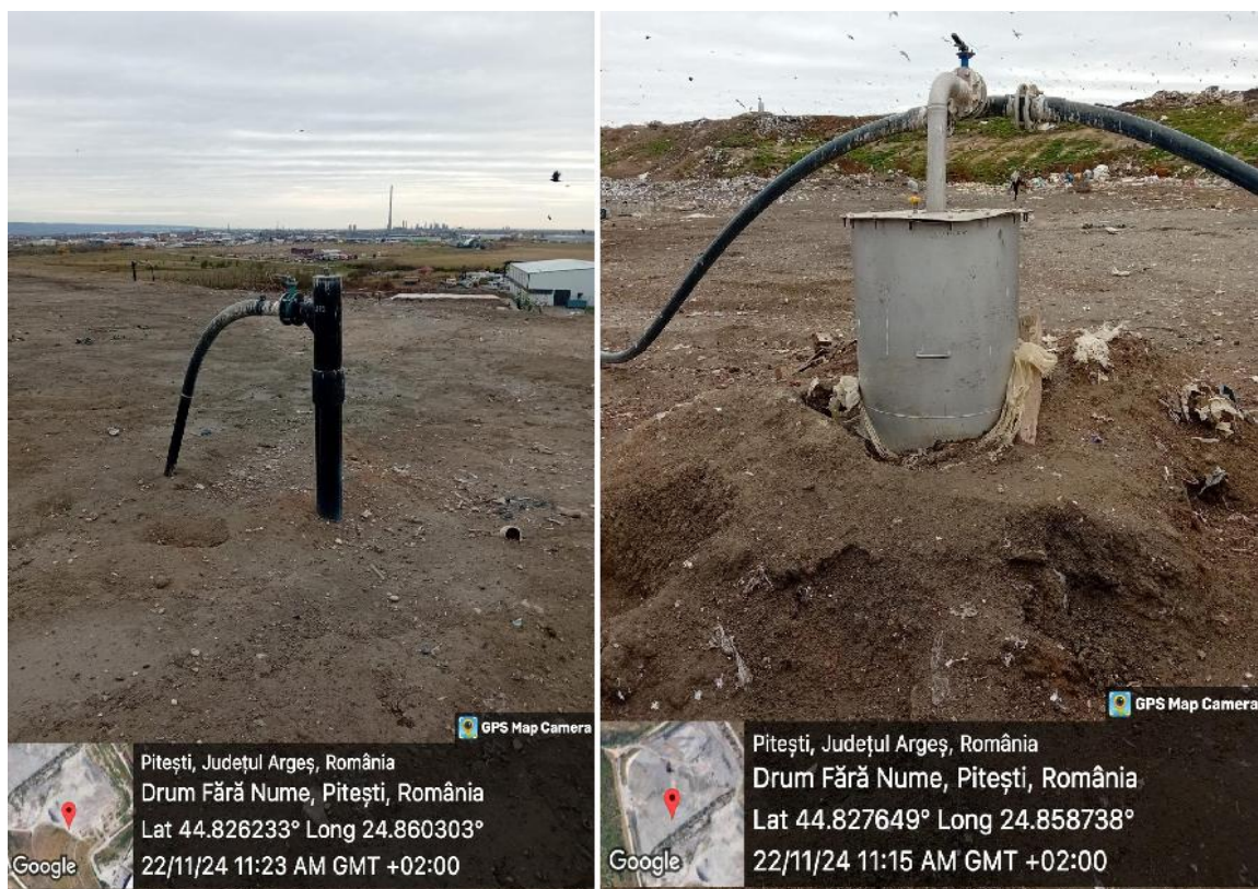
Foto 6: Sistemul de degazare a gazului de depozit pe celula nr. 1 (stanga) si celula nr. 2 (dreapta)
