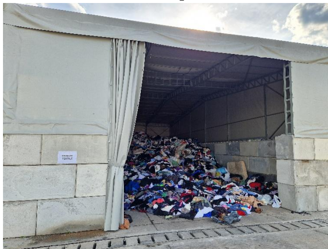
Foto 4: Hala textile pe structura de metal, anexa a statiei de sortare
