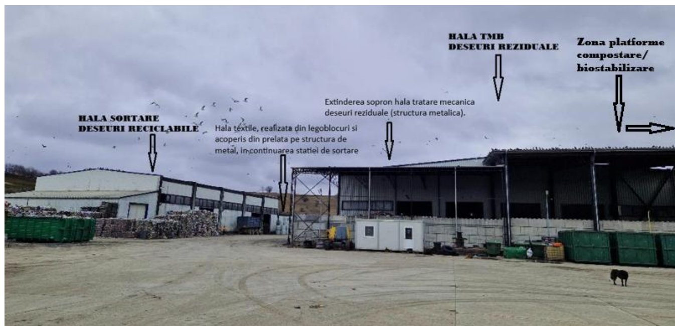
Foto 1: Principalele instalatii de tratare a deseurilor solide existente pe amplasamentul CMID Albota (vezi si capitolul V.6. Compostul si CLO-ul)
